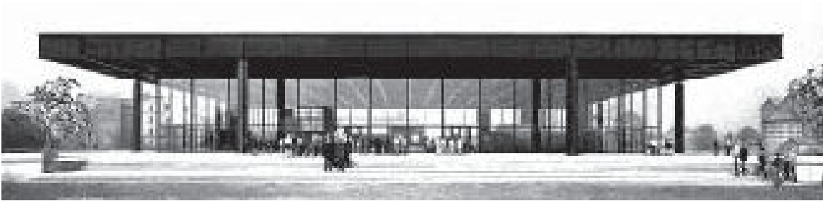
Galeria Nacional, Berlim, Ludwig Mies van der Rohe, corte, planta e vista
